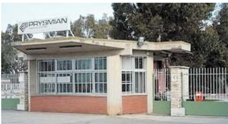
Le eccellenze Lo stabilimento Fca di Pomigliano, in basso la sede distaccata a Battipaglia della Prysmian leader mondiale per la produzione di cavi in fibra ottica
