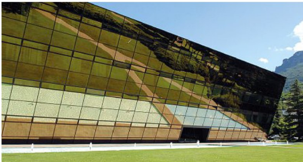
Palazzo Stella Confindustria ha lanciato la propria piattaforma Welfare Trentino per cercare di mettere a fattor comune i servizi (Rensi)
